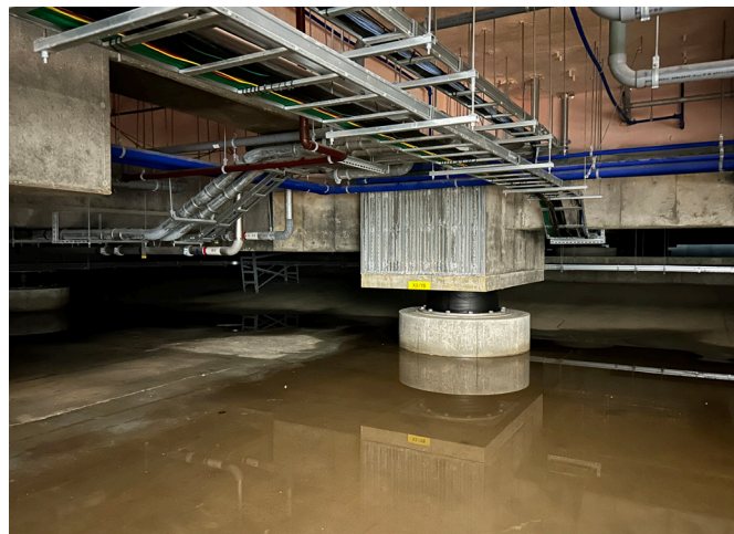
地下階にある免震構造 この空間は貯水槽としても機能する
