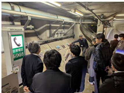
アクアトンネルの床版下避難通路
