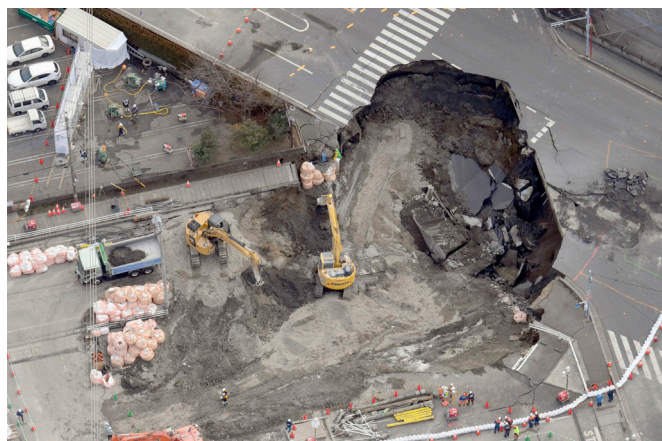
県道が陥没しトラックが転落した事故の現場＝埼玉県八潮市(毎日新聞社提供 2月3日撮影)
