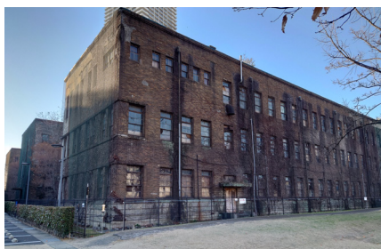
広島大学旧理学部1号館
