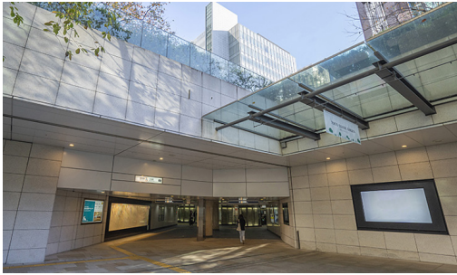
再開発ビルとの接続(銀座線京橋駅)
