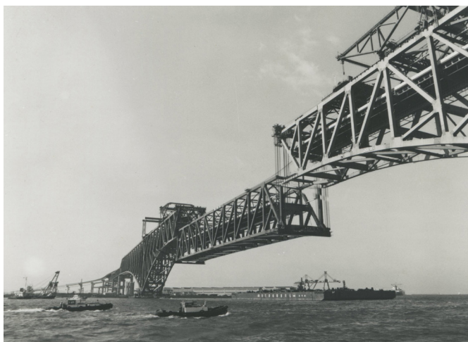
写真1 中央径間部の一括架設の様子
