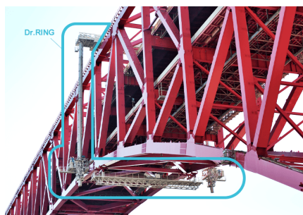
写真4 橋梁点検台車 Dr. RING
