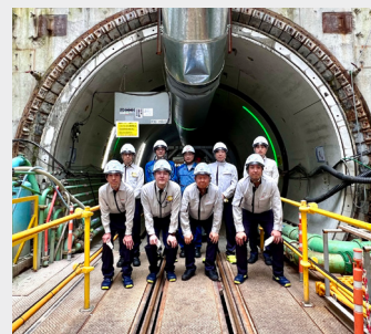
東京電力PG千葉印西エリア洞道新設
