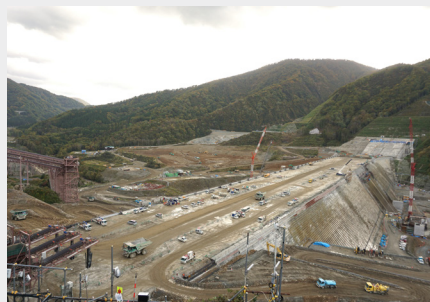
成瀬ダム施工現場
