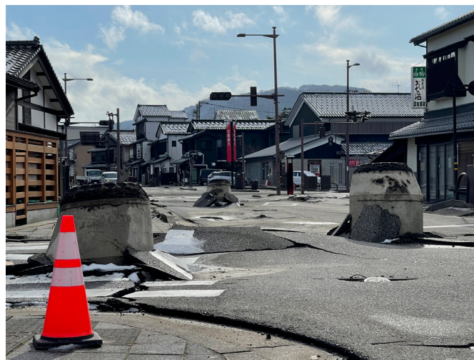
液状化により隆起したマンホール群はライフラインだけでなく避難・救援交通を寸断した(輪島市)
