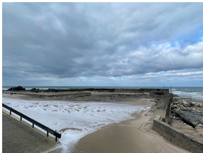
4m隆起した黒島港内では水が干上がっている
