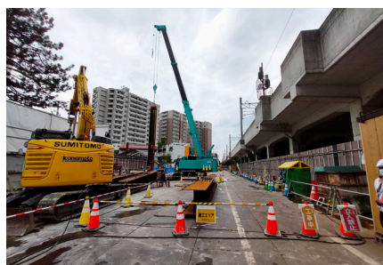
北海道新幹線工事見学(桑園地区)
