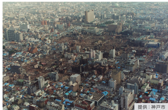
神戸市長田区の被災状況
