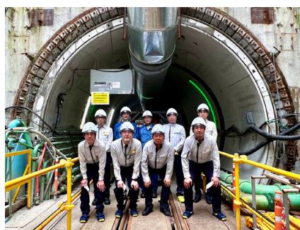
東京電力PG千葉印西エリア洞道新設
