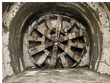
岩塊撤去状況
