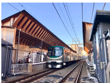
リニューアルした戸越銀座駅の木造ホーム屋根工事
