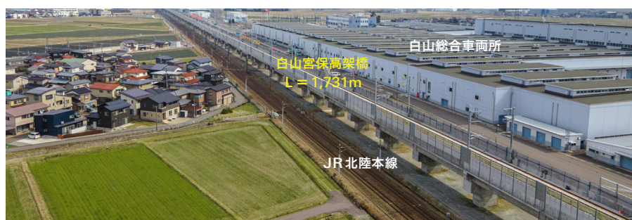
施工場所全景
