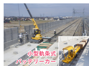
高架橋上の施工状況
