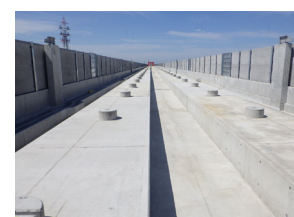
高架橋上の全景
