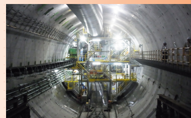
東名JCTシールド工事の見学
