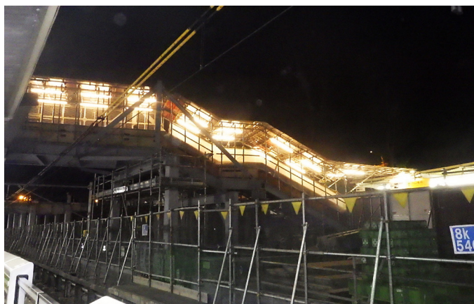
初詣の旅客対応用に設置した仮跨線橋
