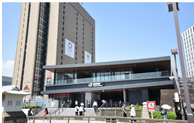
完成後の飯田橋駅西口駅舎
