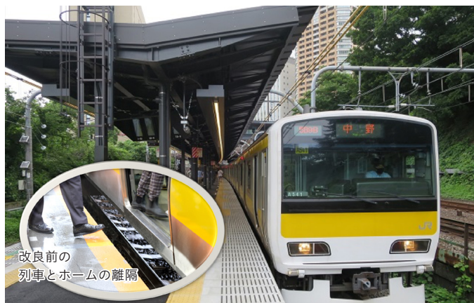
移設後の飯田橋駅ホーム
