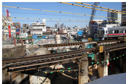
写真2 井の頭線交差部の工事状況
