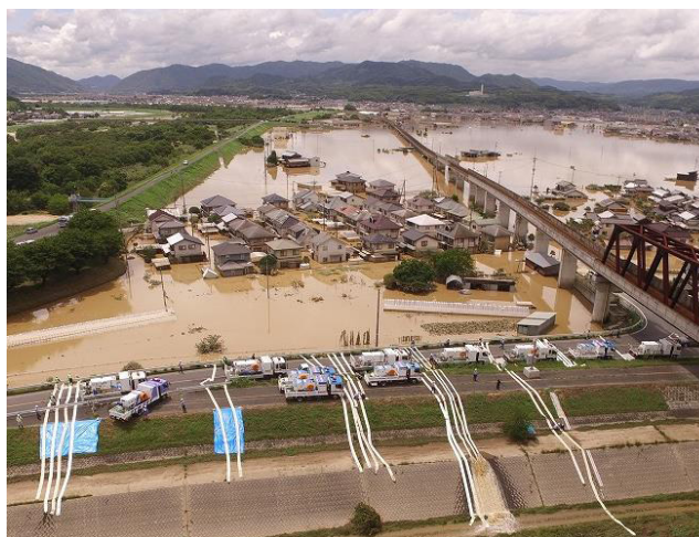
写真-3 岡山県倉敷市真備町での緊急排水
