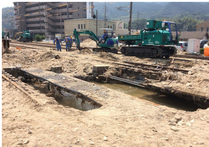
瀬野駅土砂撤去作業
