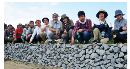
完成した石積み
