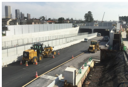
菅野函体付近の工事の様子
