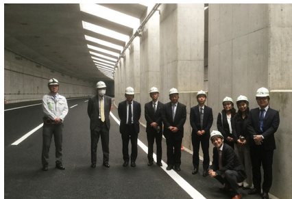
日差し対応を施した半地下構造の函体内
