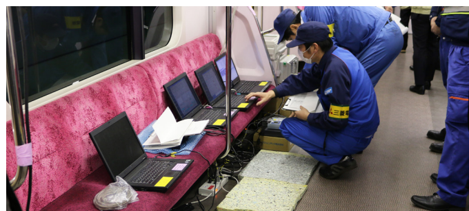
試運転車両内での信号確認作業
