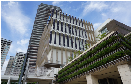
エネルギー棟(電力融通装置、特高受変電設備、太陽光発電、蓄電池を備えた先進施設)
