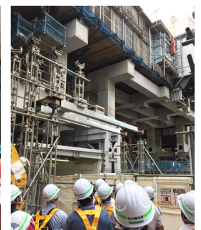
渋谷駅改良工事現場見学の様子
