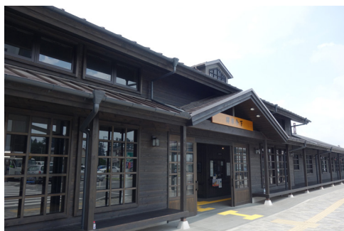
写真1 昭和レトロに改修した下今市駅
