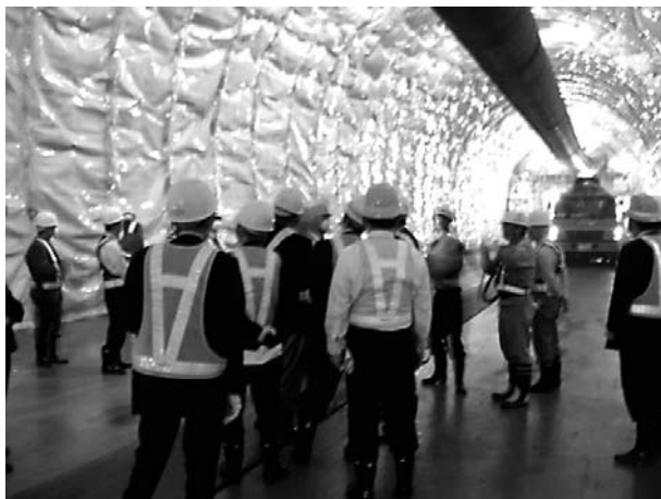
▲九州新幹線筑紫T現場
