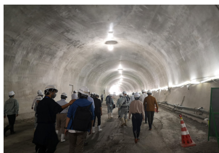
赤嶺トンネル工事現場
