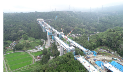
写真2 建設中の新東名(神奈川・静岡県境区間)
