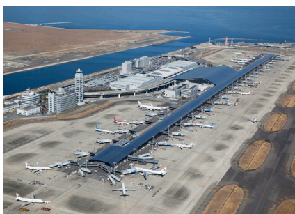
関西国際空港(写真提供：関西エアポート株式会社)
