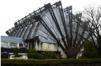
旧都城市民会館(写真提供:ドコモモ・ジャパン)
