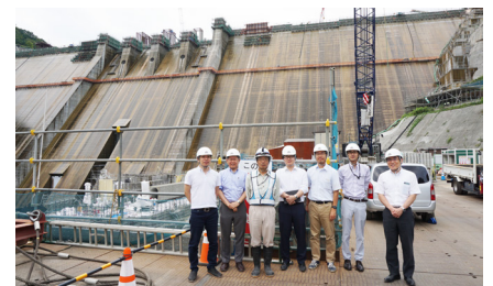
完成間近のハツ場ダムの堤体を前にして
