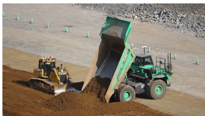
ダム工事での自動化施工状況
